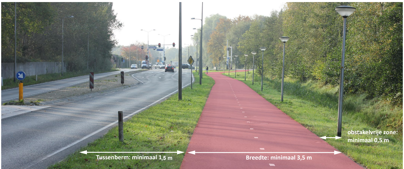
Afbeelding 6 | Voorbeeld vrijliggend tweerichtingsfietspad langs een gebiedsontsluitingsweg op het regionale netwerk (Foto: W.J. te Morsche)
