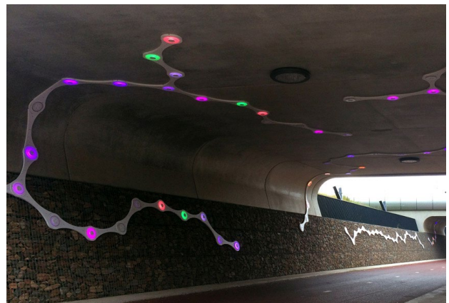
Afbeelding 37 | De onderdoorgang Rijnwaalpad
