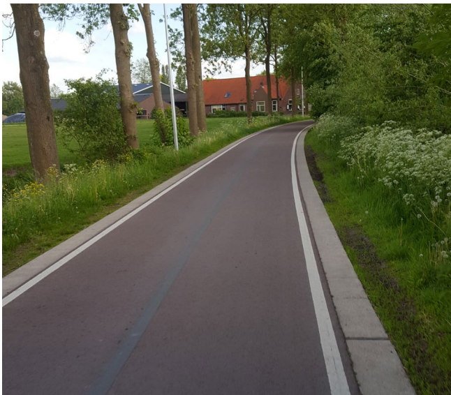
Afbeelding 4 | Voorbeeld solitair fietspad met kantmarkering en verharding (Foto: M. Wink)
